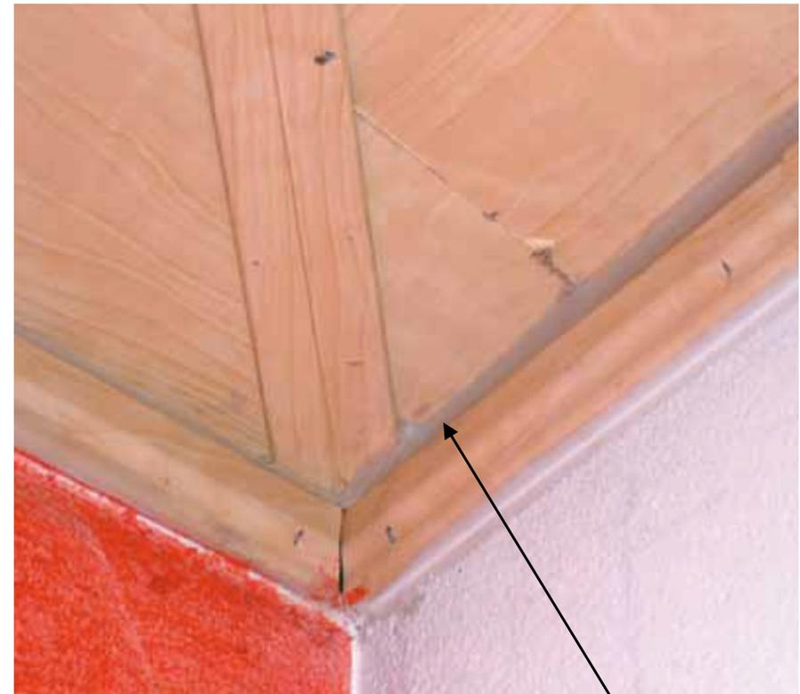
Verdächtig: Blendleisten bei Deckenverkleidungen müssen nicht verfugt werden. Die Folie liegt i.d.R. dahinter. Hier ist mit größerem Pfusch hinter der Deckenverkleidung zu rechnen
