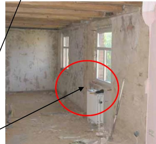
**Dämmung der Heizkörpernischen. Warme Heizkörperluft hat hohe Thermik und entweicht durch Leckagen an der Luftdichtheitsebene. Trifft dann auf kalte Außenwände und kondensiert.**
