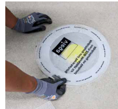
System Viega: Der Bodenablauf besitzt einen Klebeflansch, auf welchem die Verbundabdichtung appliziert wird.
