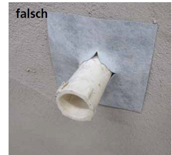
Die Dichtmanschette wurde eingeschnitten, um sie über den Baustopfen stülpen zu können.
