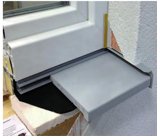
Abbildung 7: schematische Darstellung des Fensterbankvorsprungs bei einer Aluminiumfensterbank und einer Steinfensterbank
